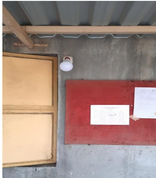
Kharda - Sonegaon Rd, Kharda, Maharashtra 413204, India Latitude 18.634565° Longitude 75.469069° LOCAL 11:16 AM THURSDAY 01.10.2020 GMT 05:46 AM ALTITUDE 500 METER
